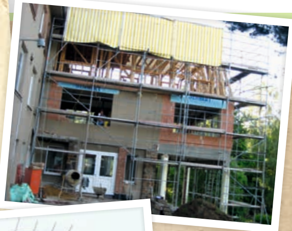
Blick auf die Baustelle Aufnahmejahr 2005, Bürgerheim Meerane gGmbH
